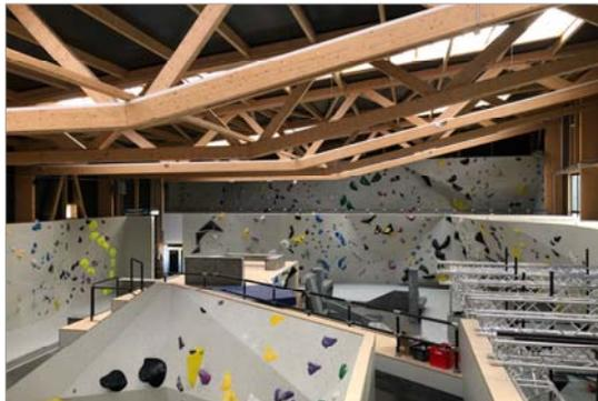
Auf einer ehemaligen Lagerfläche im Aicherpark entsteht eine neue Turn- und Sporthalle m. Büroräumen, Außenflächen und Parkplatz. Die Halle wird im Holzrahmenbauweise mit einem Dach aus Fachwerktragsystem erstellt. Das Bauwerk wird auf einer Grundstücksfläche von gut 3300 m<sup>2</sup> erstellt und wird über eine Geschossfläche von gut 1800 m<sup>2</sup> verfügen. Das Gebäude wird ohne Keller erstellt und weist eine Größe von gut 49 x 27 m und einer Höhe von knapp 12 m auf.
