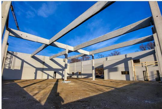
Errichtung einer Produktionsstätte der Gebäudeklasse drei in Fertigteilbauweise. Die tragenden Wände und Stützen der neu errichteten Halle sind aus Stahlbeton, genau wie das Tragwerk des Daches. Das Dach selbst ist ein Blechdach in Form von Sandwichpaneelen, ebenso wie die Fassade. Die Zwischendecken wurden in Ortbeton ausgeführt.
